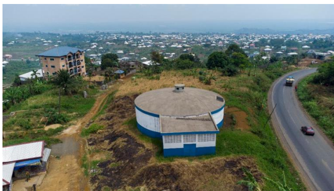
Réseau d'adduction en eau potable dans la Commune de Tiko
