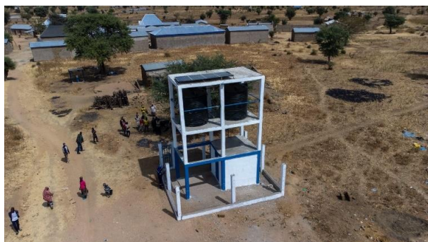
Adduction en eau potable dans du village Oudava localité située dans la Commune de Mogodé
