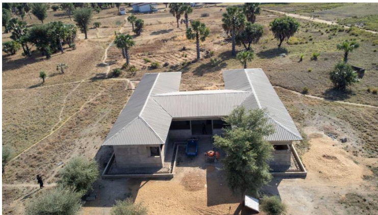
Centre de Sante Intégré (CSI) du village Djaŋga, dans la Commune de Kai-Kai
